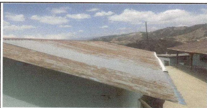
Foto 5: Sustrucción de lámina, por lámina troquelada.
