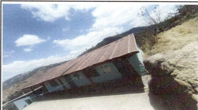
Foto 2.2: Sustrucción de soporte de madera por metal.
