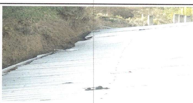
Foto 6: Sustrucción de lámina, por lámina troquelada.
